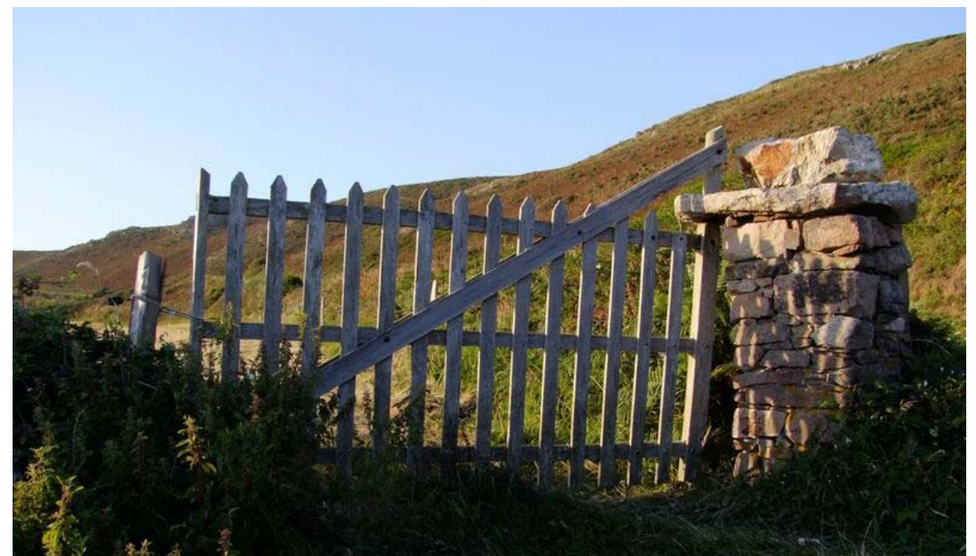
Figure 12. Portails « barrière à écharpe »
