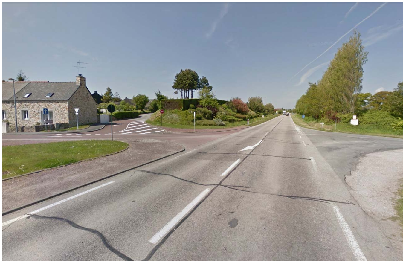
Figure 10. Vue de la RD650 « Route de la côte »
