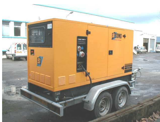
Remorque groupe électrogène 60 kva, 380v tri pour intervention rapide
