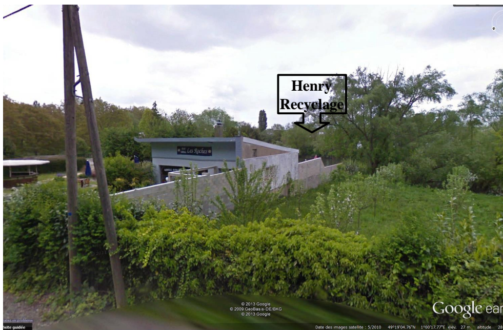
Photo n° 7 : Vue n °7 depuis l'autre rive de la Seine (Route des Roches)
