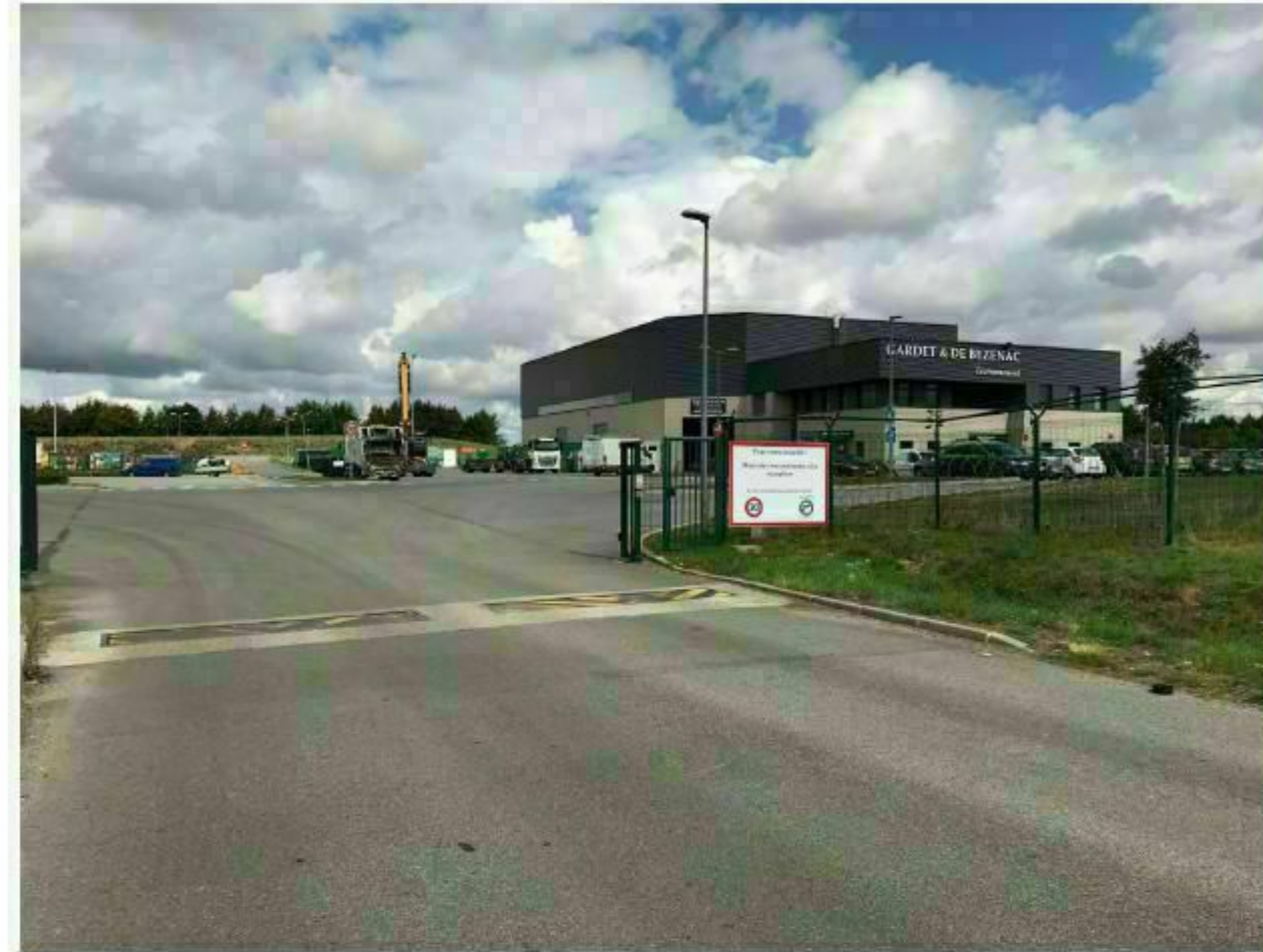
1- Bâtiment principal (ligne plastique)
