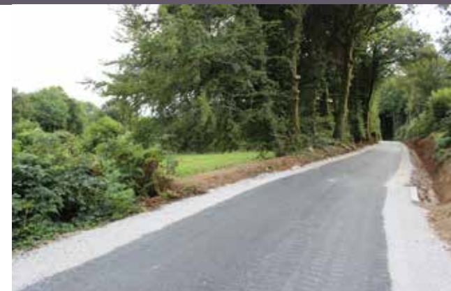
Requalification chemin de la Rouxellerie
