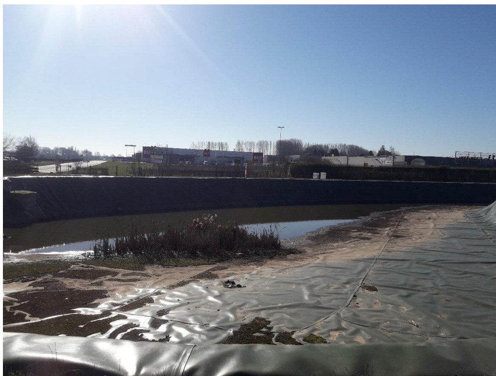
Photographie 11 : Bassin de rétention des eaux pluviales
