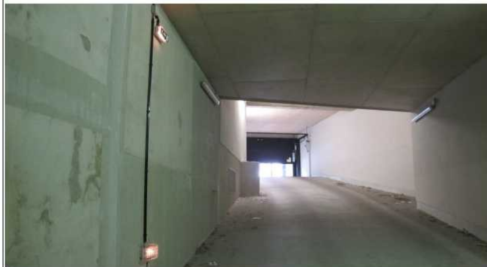
La signalisation nous dirige vers une sortie motorisée non ouvrable manuellement
