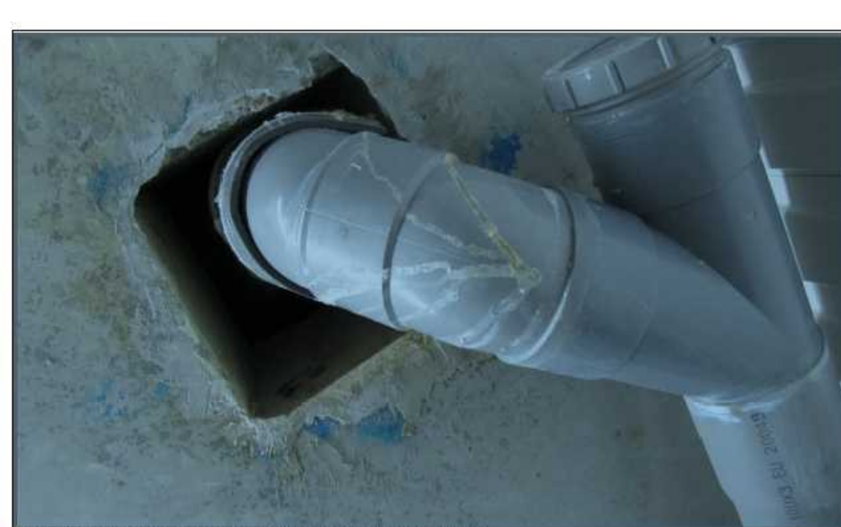
Pas de rebouchage gaine entre parc et logements
