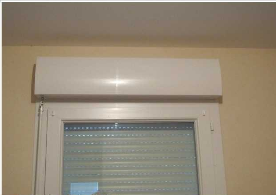
Pas d'entrée d'air sur fenêtre de chambre
