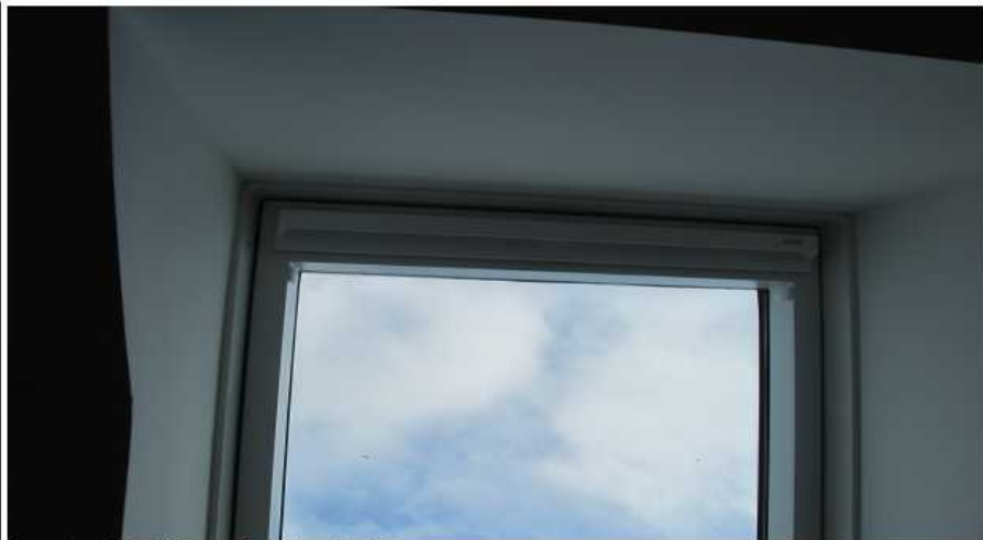
Pas d'entrée d'air sur fenêtre de toit
