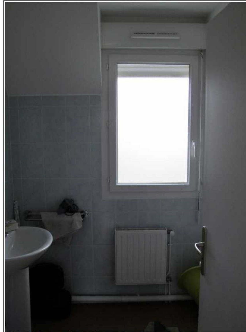
Entrée d'air dans une pièce humide
