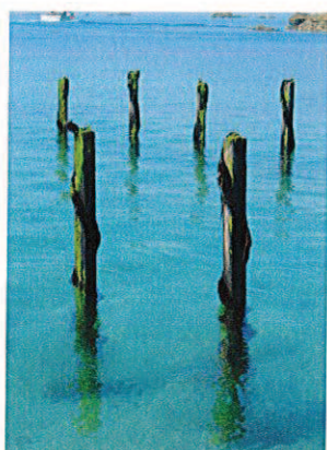
Figure 24 : Phase 3 : cordes enroulées autour des pieux (BMI Normandie – ONCFS)
