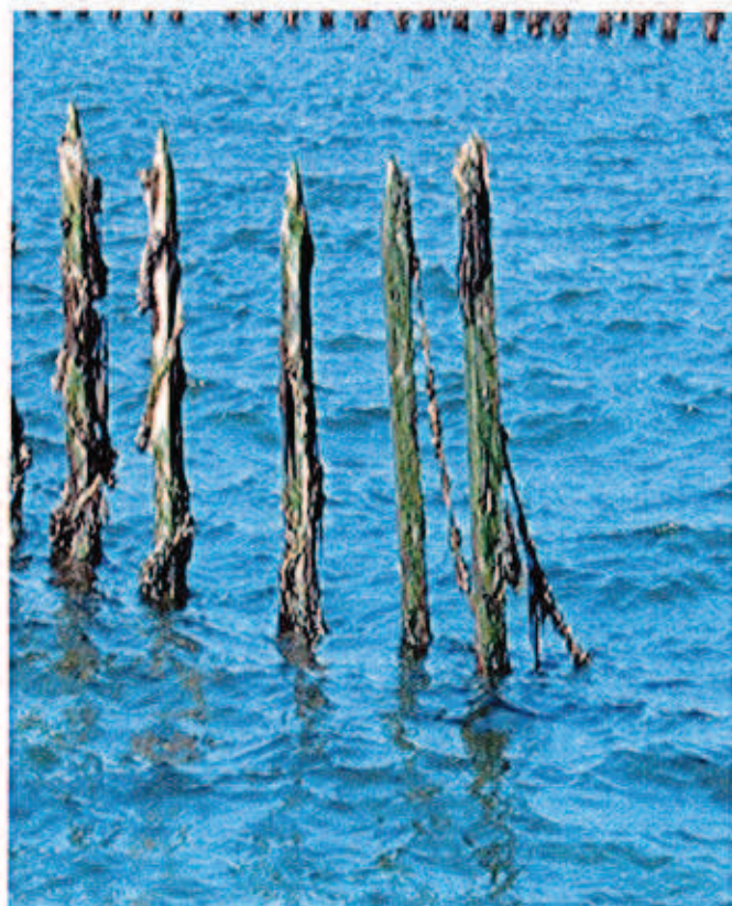
Etat des pieux après prédation
