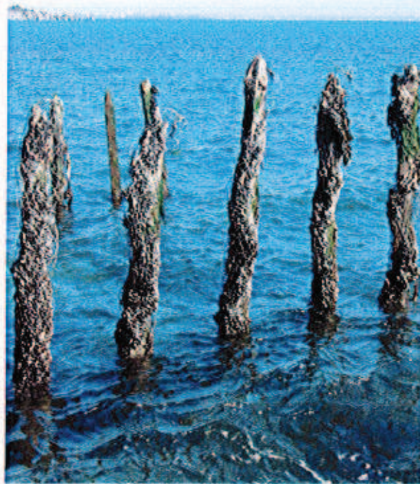
Etat des pieux après prédation (Autre exemple)
