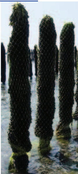
Figure 10 : Pieu indemne de prédation
