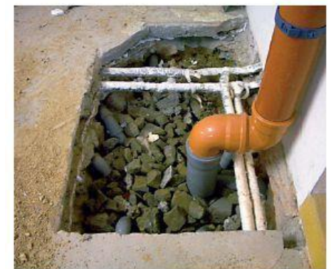
Ventilation ponctuelle (puisard à radon) – Excavation d'un puits
