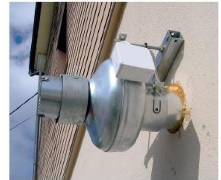
Un ventilateur situé à l'extérieur permet de créer une légère dépression sous la dalle
