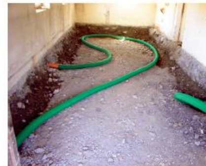
Rénovation de la structure sous le plancher : pose d'un système de drainage du radon
