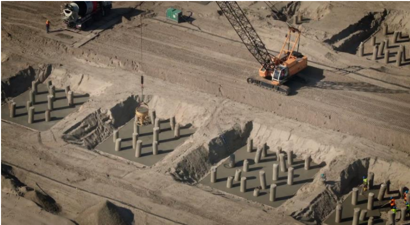
Exemple de travaux de construction (usine de Cuxhaven)
