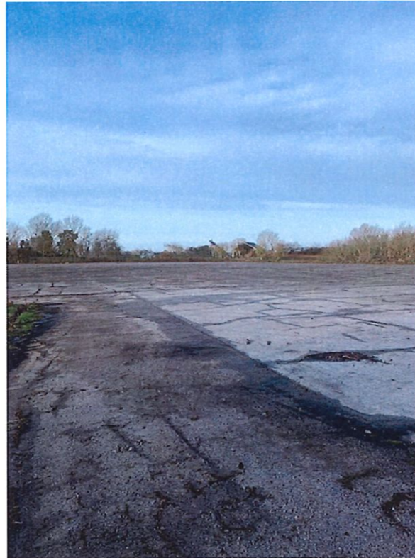
Photo n°2 : vue depuis la plateforme vers les installations CASEMA
