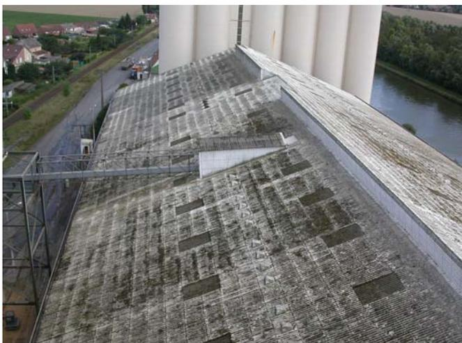
*Figure 13 : Couverture en fibrociment*
