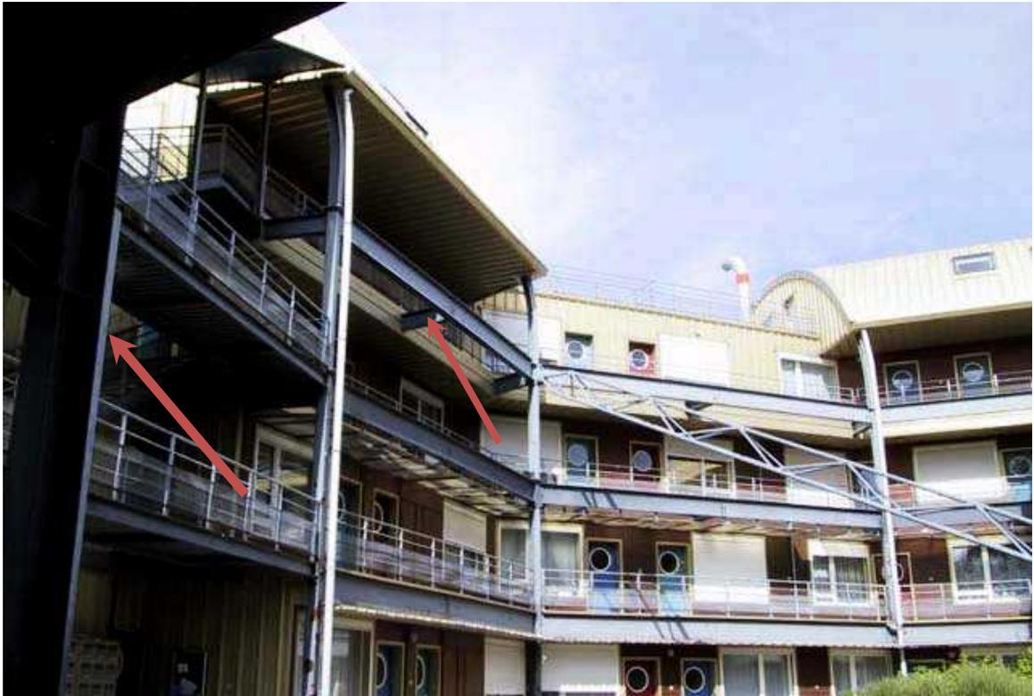
*Figure 2 : Structure métallique avec structure porteuse apparente (exposée)
