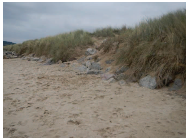
Perré en enrochements ensablés, entre les épis n°8 et 9
