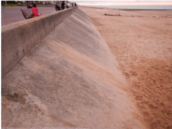
Perré en béton entre la cale est et l'épi n°10
