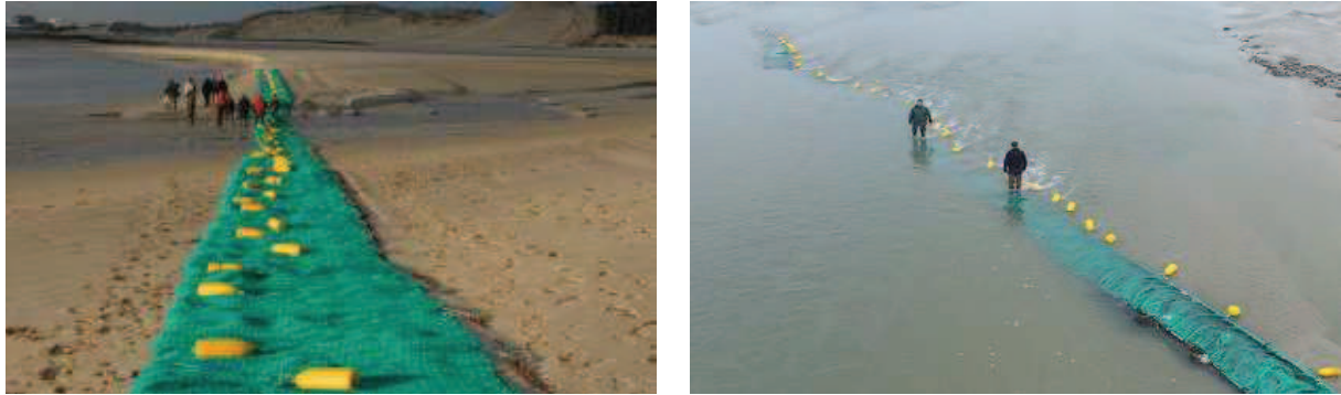
Figure 14 : autres vues du procédé S-ABLE mis en œuvre en milieu intertidal, en bordure de chenal, à marée basse à g. et marée montante à d. (source : S-ABLE)
