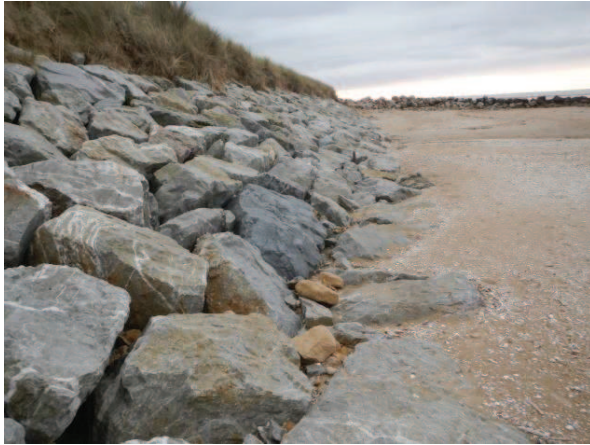
Perré en enrochements, entre les épis n°5 et n°6
