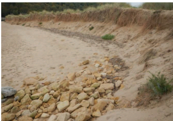
Forte érosion de la dune à l'Est immédiat de l'épi n°1
