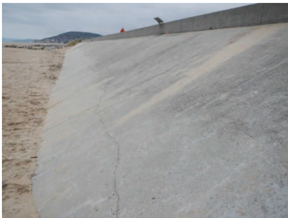
Perré en béton, entre la cale est et l'épi n°9
