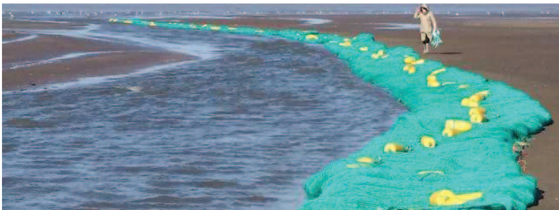
Figure 13 : photographie du procédé S-ABLE mis en œuvre en bordure de chenal estuarien (source : S-ABLE)
