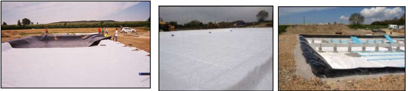
Fig.4.1. Exemple pose géotextile et géomembrane ASQUAL
