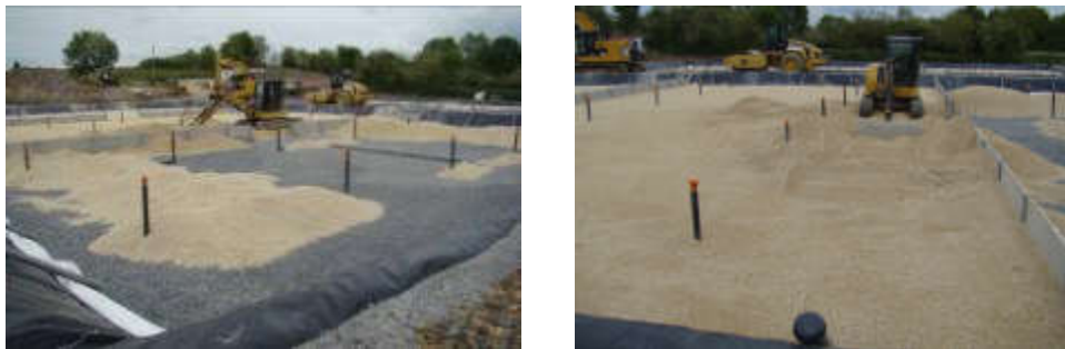
Fig.4.2. Remplissage des casiers
