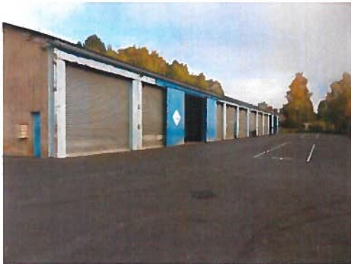
PHOTO 2 : Parcelle ouest (bâtiment + voirie)
