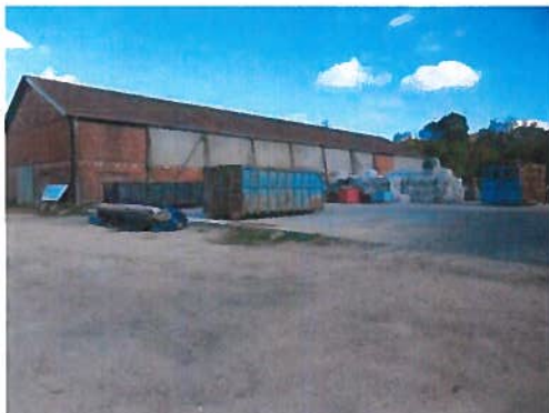
PHOTO 3 : Parcelle nord (bâtiment + dalle béton)
