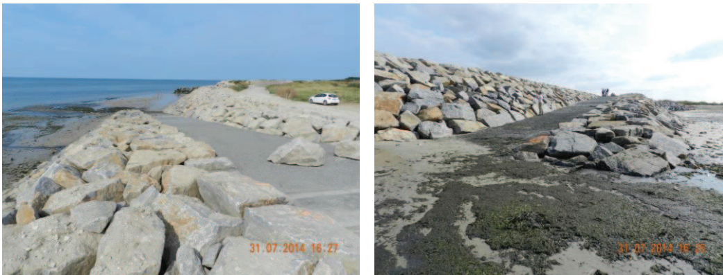
Figure 10 : Exemple récent d'une descente à la mer réalisée à Grandcamp-Maisy, dans le Calvados (Source Antea Group)
