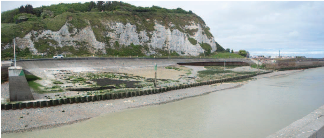
Figure 3: photographie n°1 du 06/08/2015
