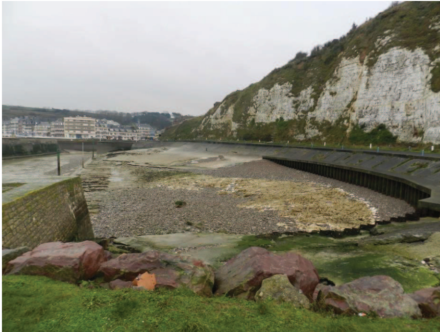
Figure 5: Photographie n°3 du 22/01/2016
