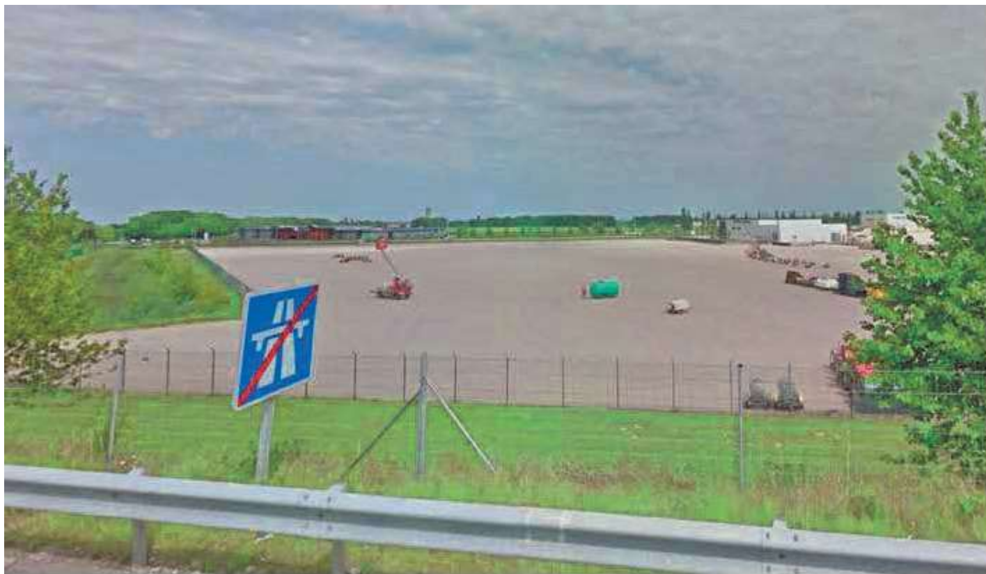
Photographie n°1 : Vue sur la plateforme depuis la sortie n°17 – Gaillon/Les Andély (27/03/18)
