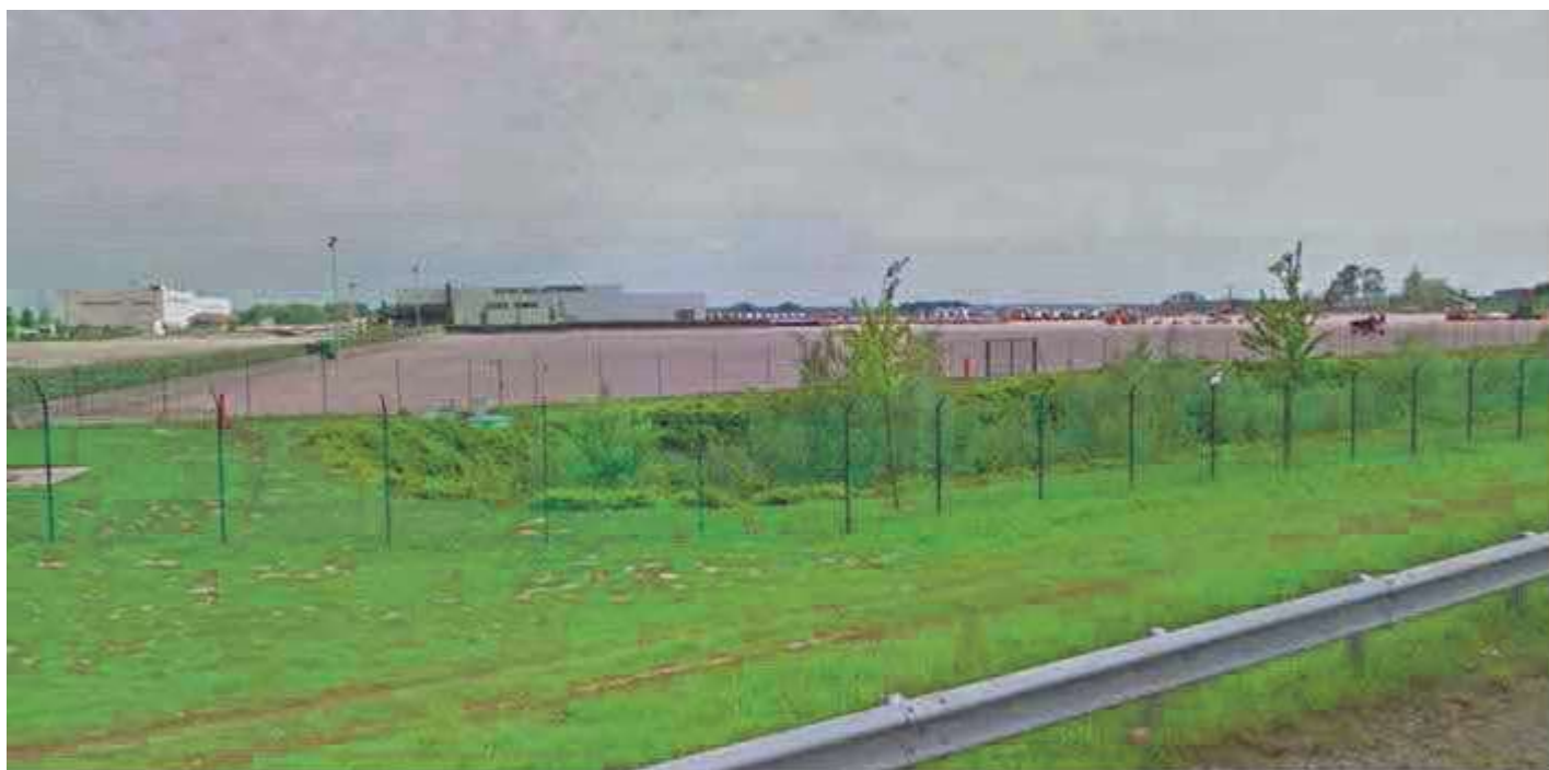
Photographie n°2 : Vue sur la plateforme depuis la RD316 à l'Ouest (27/03/18)
