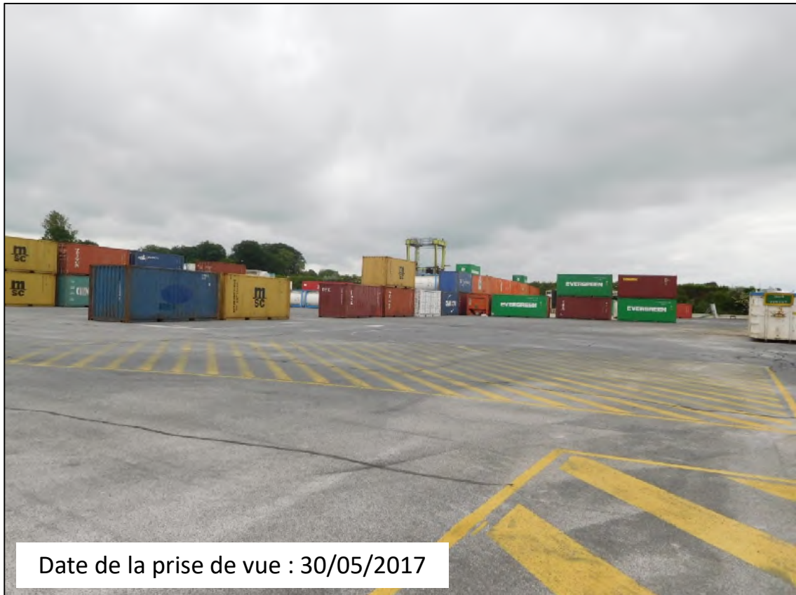
Photo 1 : plateforme de stockage des conteneurs maritimes
