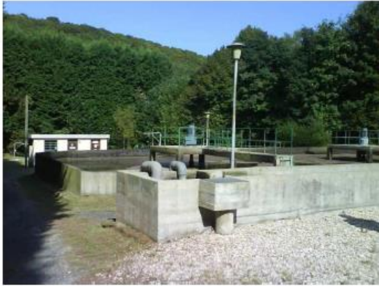
Local technique et bassin d'aération
