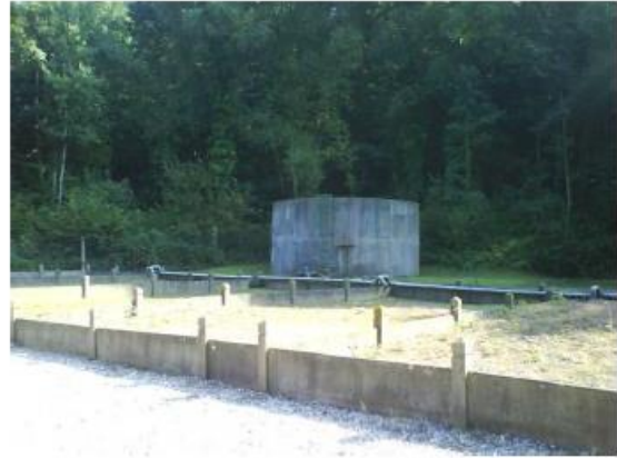
Silo et lits de séchage
