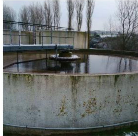
Clarificateur avec les silos au fond
