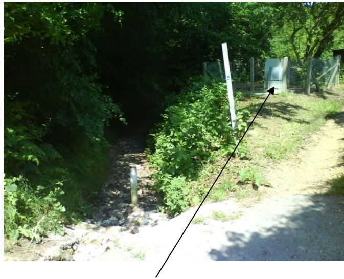
Poste existant du hameau de "La Cave". La conduite de refoulement viendra de ce bois de "La Cave".
