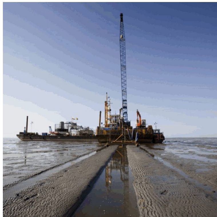
Exemple de travaux de tranchée sur estran dans sol sableux
