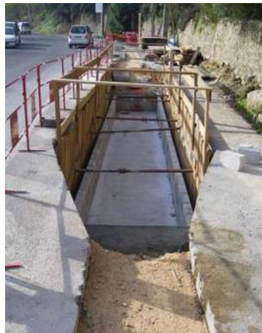
Chambres terrestres (2 tous les kilomètres) : 12 m de long 3 m de large 2 m de profondeur
