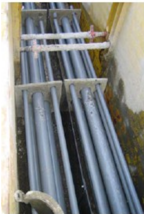
Fourreaux de 2 liaisons 225 000 volts
