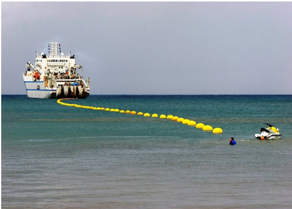
Exemple d'un tirage d'un câble vers l'estran
