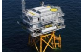
Poste électrique en mer
