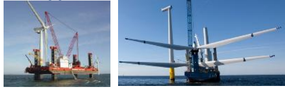
Installation des éoliennes appel d'offres début 2015
