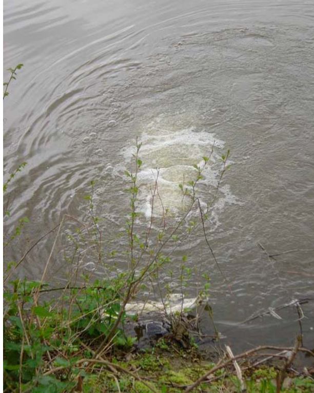
Figure 13 – Photo du rejet des eaux de surverse du barrage de la galerie I du flanc Sud
