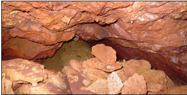
Photographie 3 : galerie des morts-terrains pour partie remblayée (May-sur-Orne, sondage D02)
