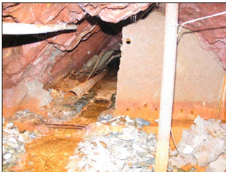
Photographie 1 : mur de béton de la galerie I pour partie démantelé
