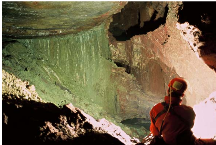
Photographie 8 : zone de glissement majeur du mur (St-Martin-de-Fontenay). Photographie D. Butaeye
