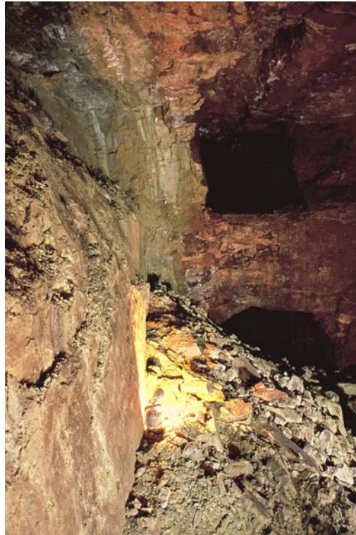
Photographie 6 : glissement de matériau argilisé au mur de la couche (St-Martin-de-Fontenay). Photographie D. Butaeye
