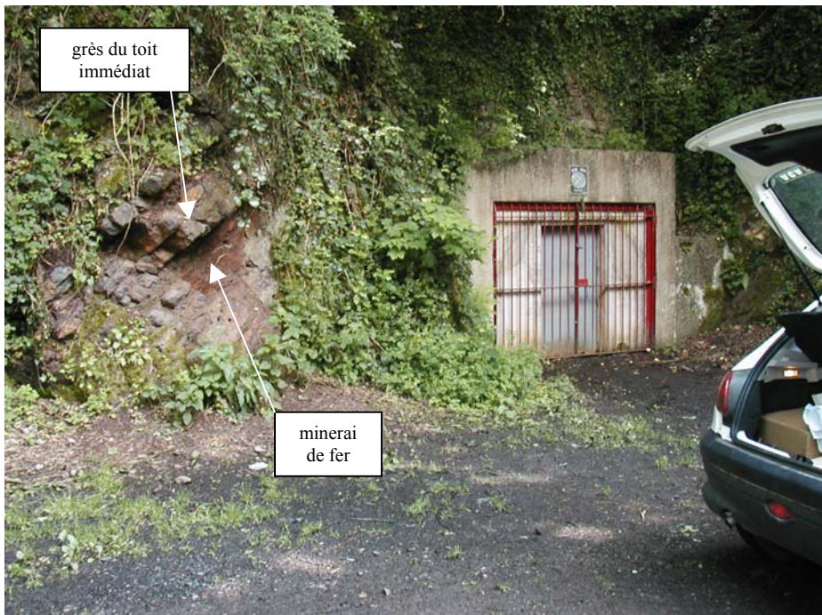
Photographie 8 – Entrée vers la galerie de niveau 1 (flanc sud)
