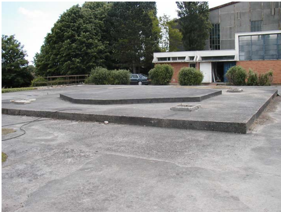
Photographie 4 – Dalle sur le puits Central
