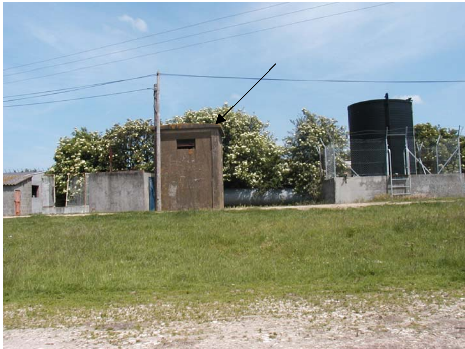
Photographie 5 – Bâtiments des pompes du puits Taraud (flanc sud)
