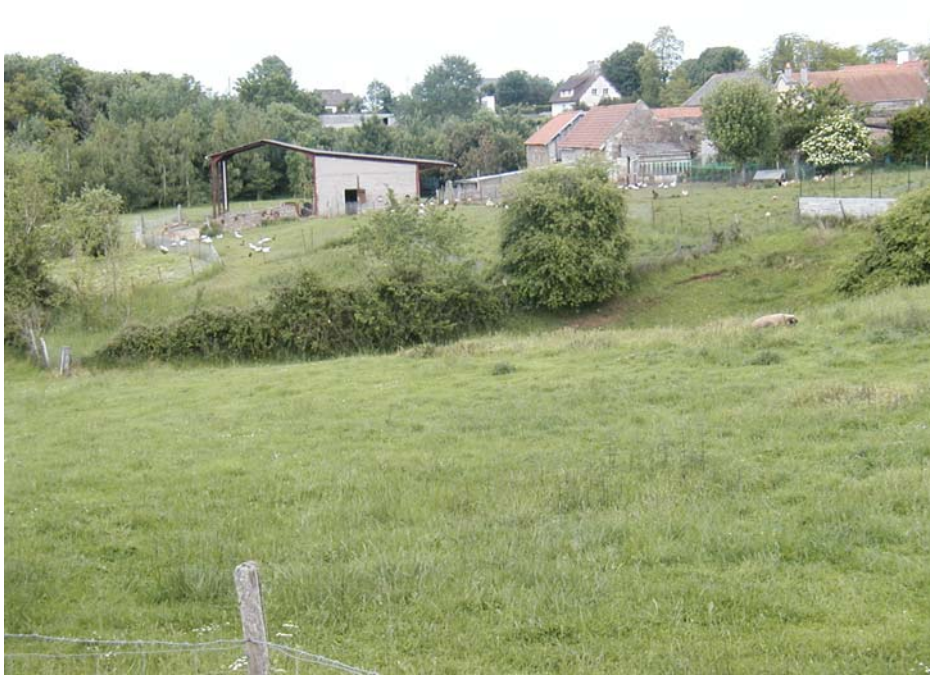
Photographie 9 – Effondrement localisé de Guillot (flanc sud hors dalle calcaire)
