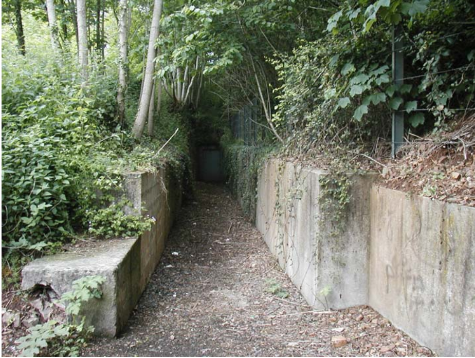
Photographie 7 – Entrée vers la galerie de niveau B (flanc nord)
