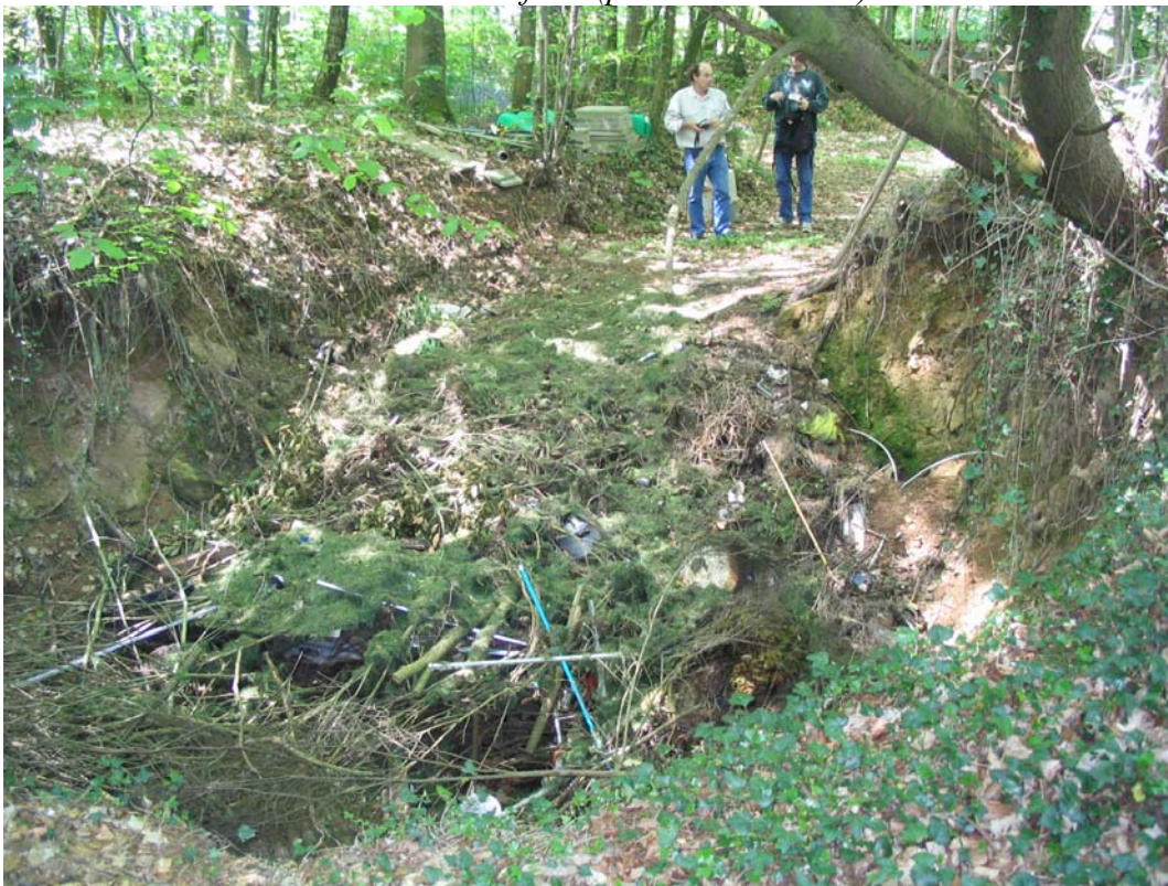
Figure 23 : Effondrement de La Fieffe. Situation actuelle.
