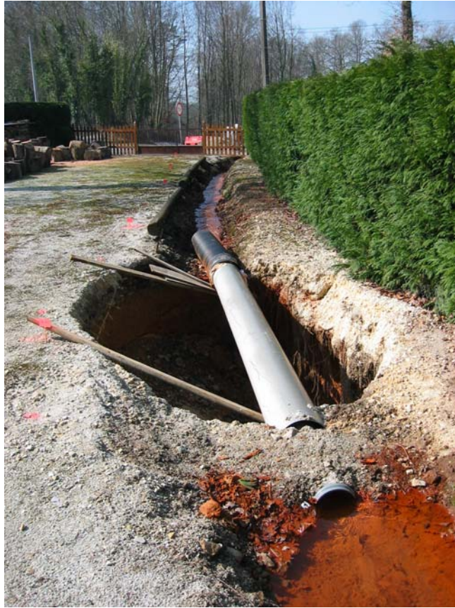
Figure 27 : exemple de fontis à l'aplomb du TB 220 (photo GEODERIS)
