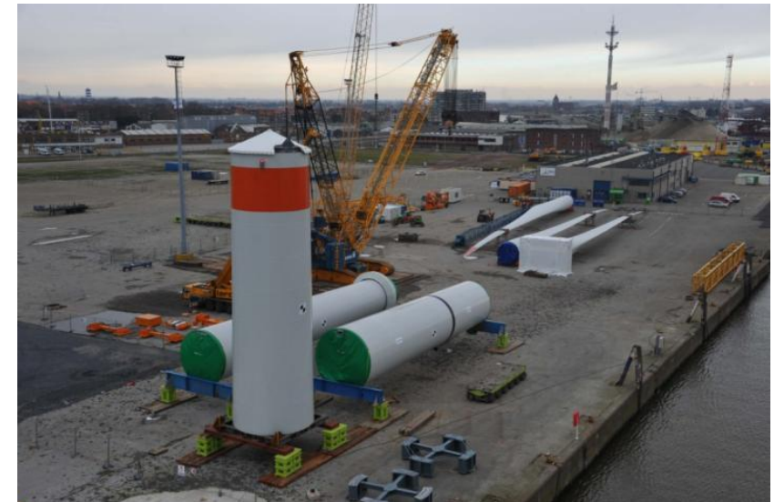
Photographie des sections de mât (Port d'Ostende)
