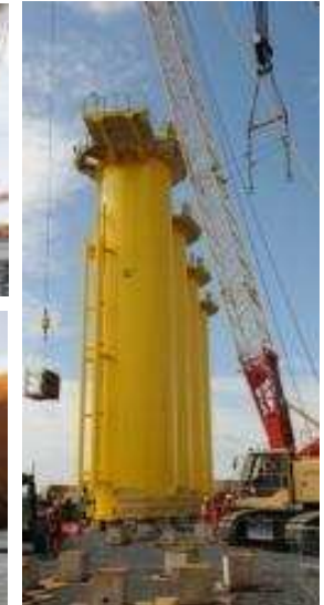
Construction des fondations monopieux du parc de Walney (DONG Energy)
