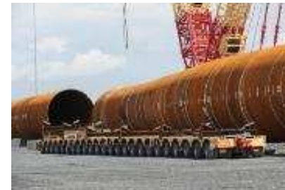
Construction des fondations monopieux du parc de Walney (DONG Energy)
