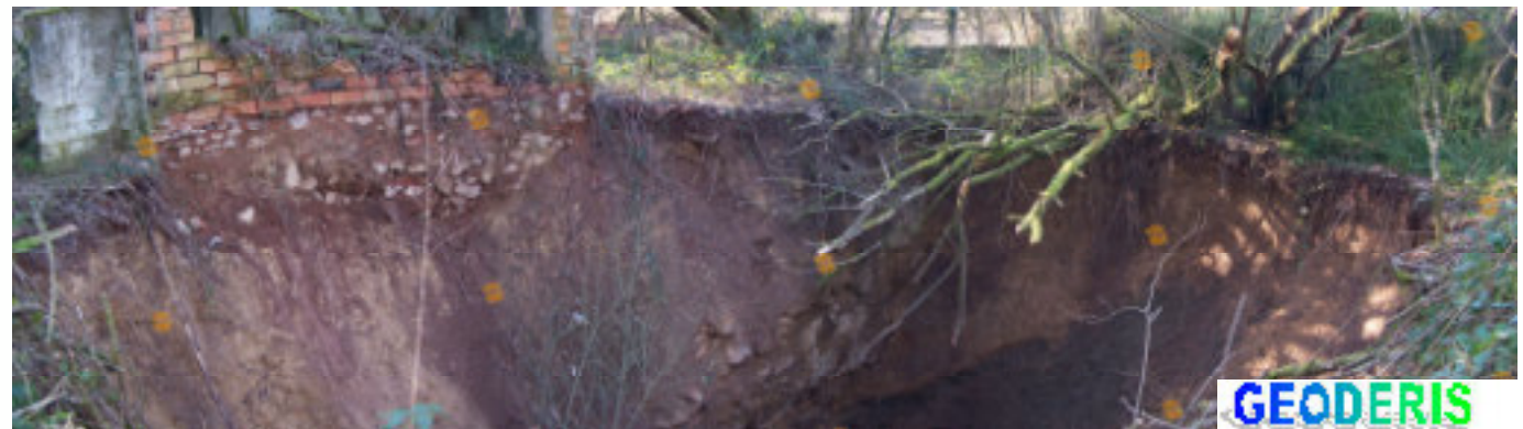
Effondrement chambres magasins 2008 (carreau Puits 1 Halouze)
