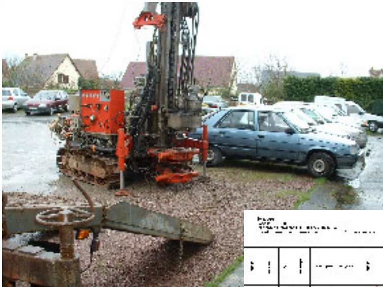
Foreuse de sondages et exemple d'un log des paramètres d'enregistrements
