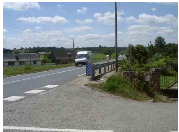
Vers Buchy Malgré la présence de la glissière, la visibilité est bonne Néanmoins, le profil en long de la VC d'environ 10% contraint le débouché de la VC sur la RD. Le débouché de la VC1 nord est à reprendre
