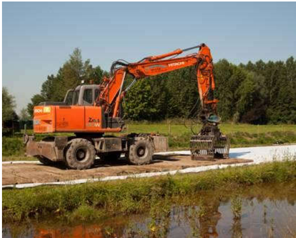
Pose de plats bords en zone humide
