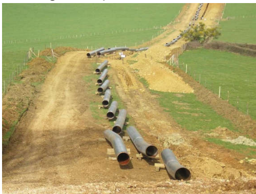
Bardage des tubes
