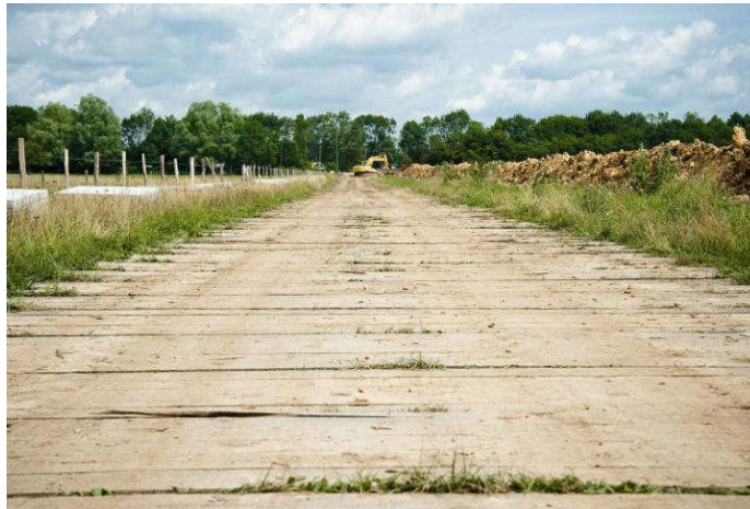
Pose de plats bords en zone humide
