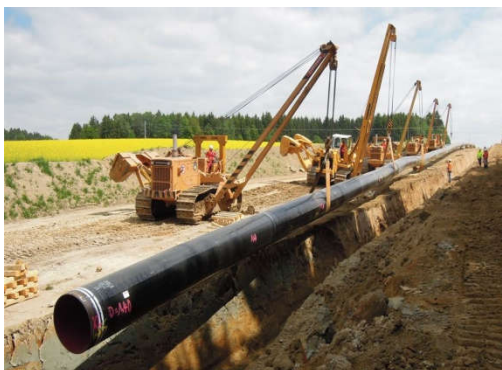
Mise en fouille
