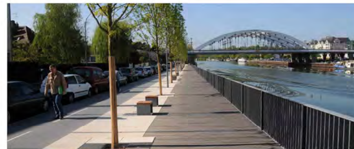
St-Ouen-l'Aumône Quai de l'écluse (Yuli Atanassov) Trottoir prolongé par un platelage bois en encorbellement.
