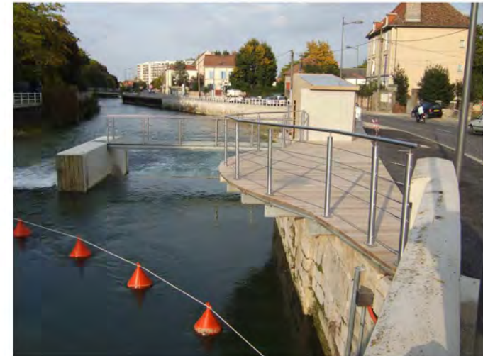
Encorbellement au-dessus de la Seine avec platelage bois et rambarde en inox à Troyes, BIEF-APLT (10).
