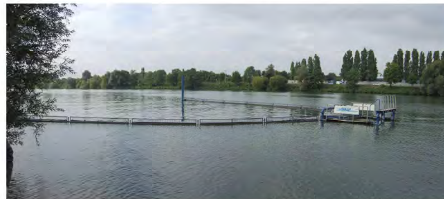
Exemple de barrage flottant mis en place actuellement sur Paris (SIAAP).
