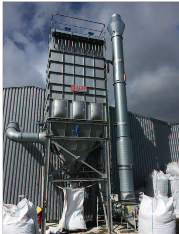
Vue sur le dépoussiéreur équipant l'établissement VALINEO
