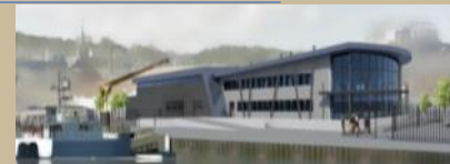
Fécamp - Base de maintenance
