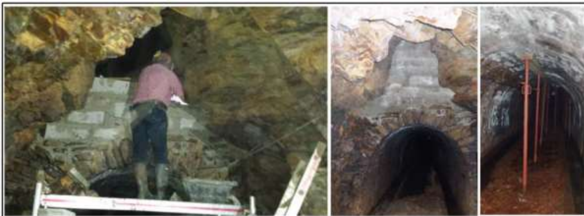
Figure 4 : Mur en parpaings et soutènement de voûte maçonnée du travers-banc au niveau de la cloche cote 263 (d'après BRGM-DPSM ; cf. [3])
