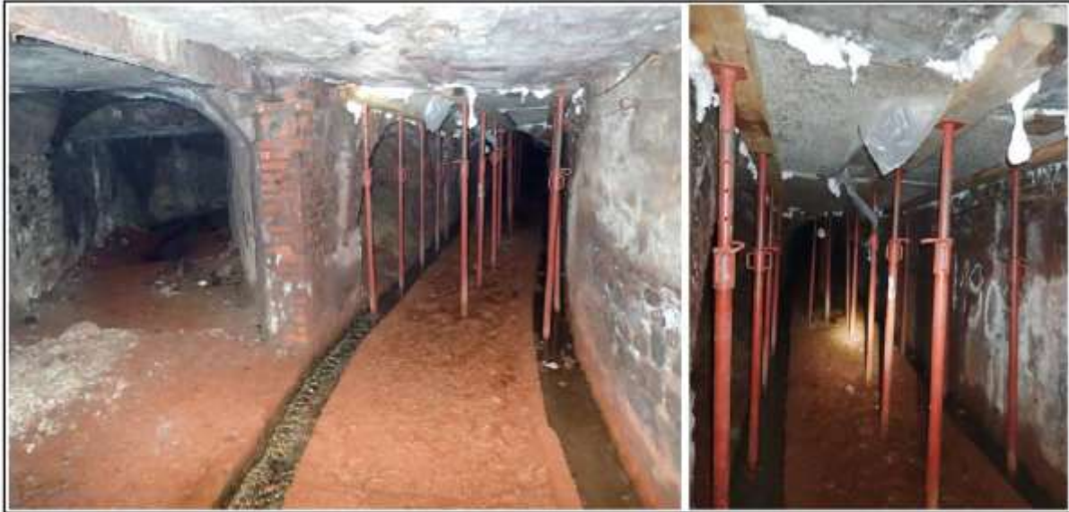
Figure 3 : Coffrage et soutènement de la cloche cote 191 (d'après BRGM-DPSM ; cf. [3])
