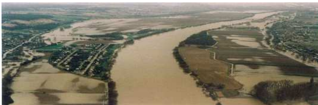
Photo 1 : Crue de la Seine (Freneuse RD et Criquebeuf-sur-Seine RG – février 1995)
