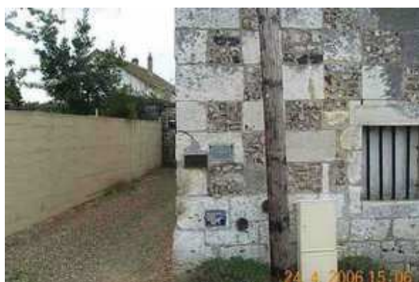
photo 19 : repères de crue de la Seine à Cléon (crues du 2/02/1910 et du 21/03/1976) (source : IGN)
