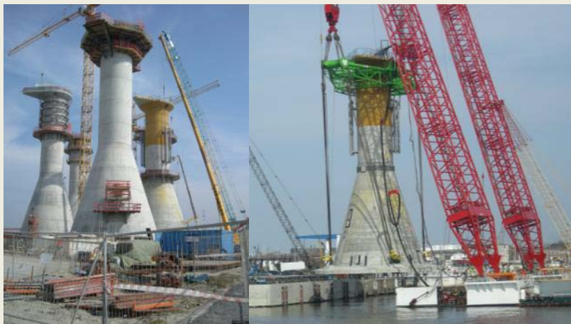
Fabrication des fondations gravitaires au Havre
