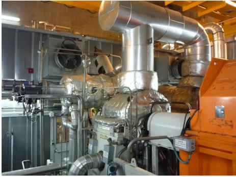
L'énergie thermique ou chaleur dégagée par la combustion des déchets permet de chauffer l'eau déminéralisée et de la transformer en vapeur, vapeur qui alimente un turbo-alternateur.
