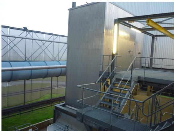
L'ammoniaque est stockée dans une cuve dédiée aux 2 lignes d'incinération. Elle est injectée dans les DENOX en amont du catalyseur. Le débit d'injection est régulé selon la concentration de NOx mesurée dans les fumées en sortie des chaudières.
