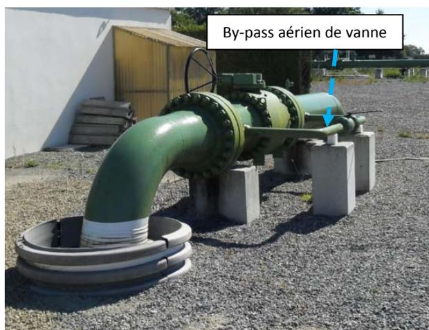
Figure n° 5 : Exemple de by-pass de vanne aérien
