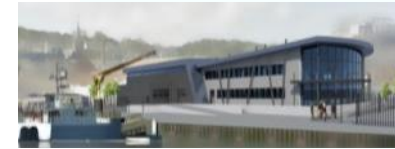
Fécamp Base de maintenance ~ 100 personnes
