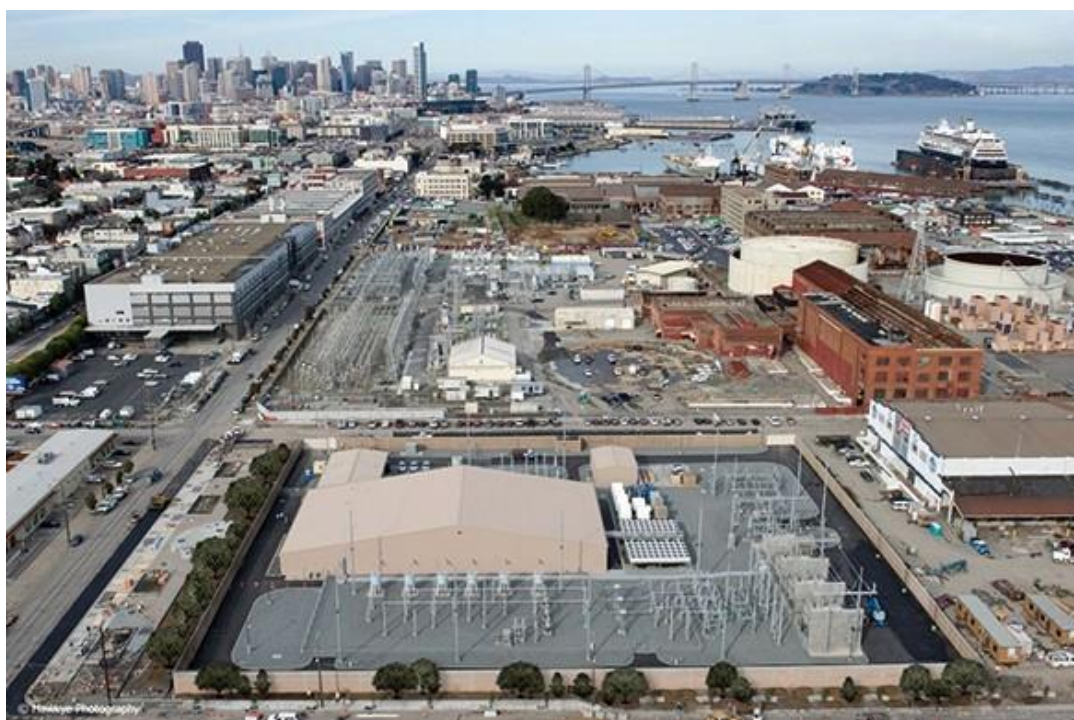
Figure 56 : Station de conversion compacte en milieu urbain à San Francisco
