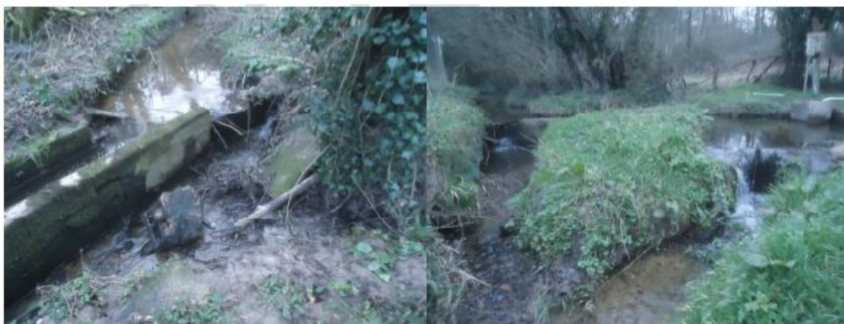
Figure 13 : Illustration photographique du canal d'alimentation du plan d'eau au lieu-dit les Planquettes (à gauche) et du seuil établi en aval pour maintenir le niveau d'eau d'un bassin anciennement utilisé comme lavoir (à droite).
