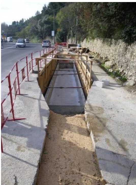
Figure 7 : Exemple de chambre de jonction avant remise en état de la chaussée (RTE)
