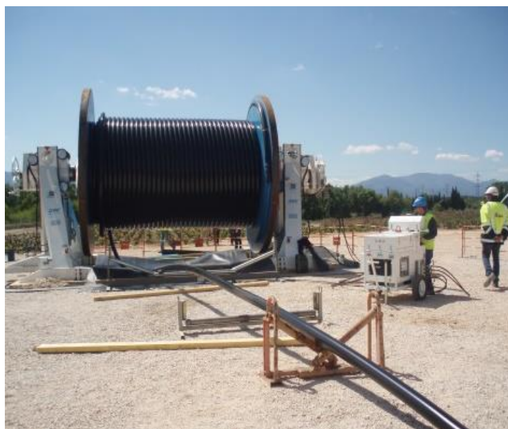
Figure 8 : Câble sur touret (RTE)
