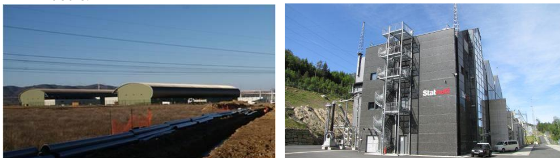
Figure 10 : Bâtiments installés dans la station de conversion de 2000MW de Baixas (source : RTE) et de 700MW de Feda en Norvège (source : Statnett)
