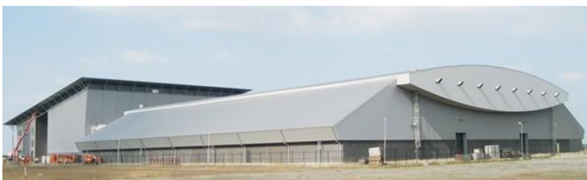
Figure 55 : Station de conversion aux Pays-Bas
