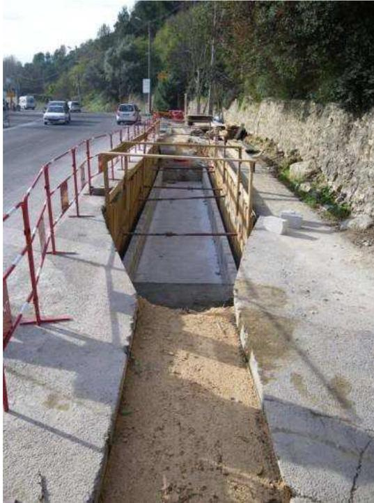
Figure 15 : Exemple de chambre de jonction avant remise en état de la chaussée (RTE)
