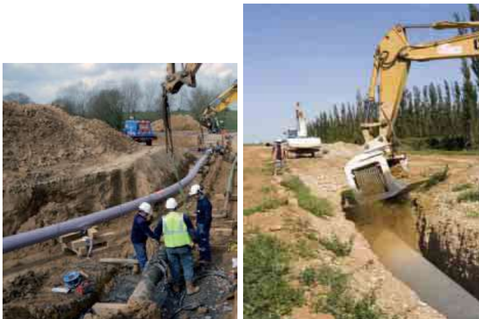
Figure n° 8 : Pose et remblai de la tranchée
