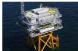
Poste électrique en mer
