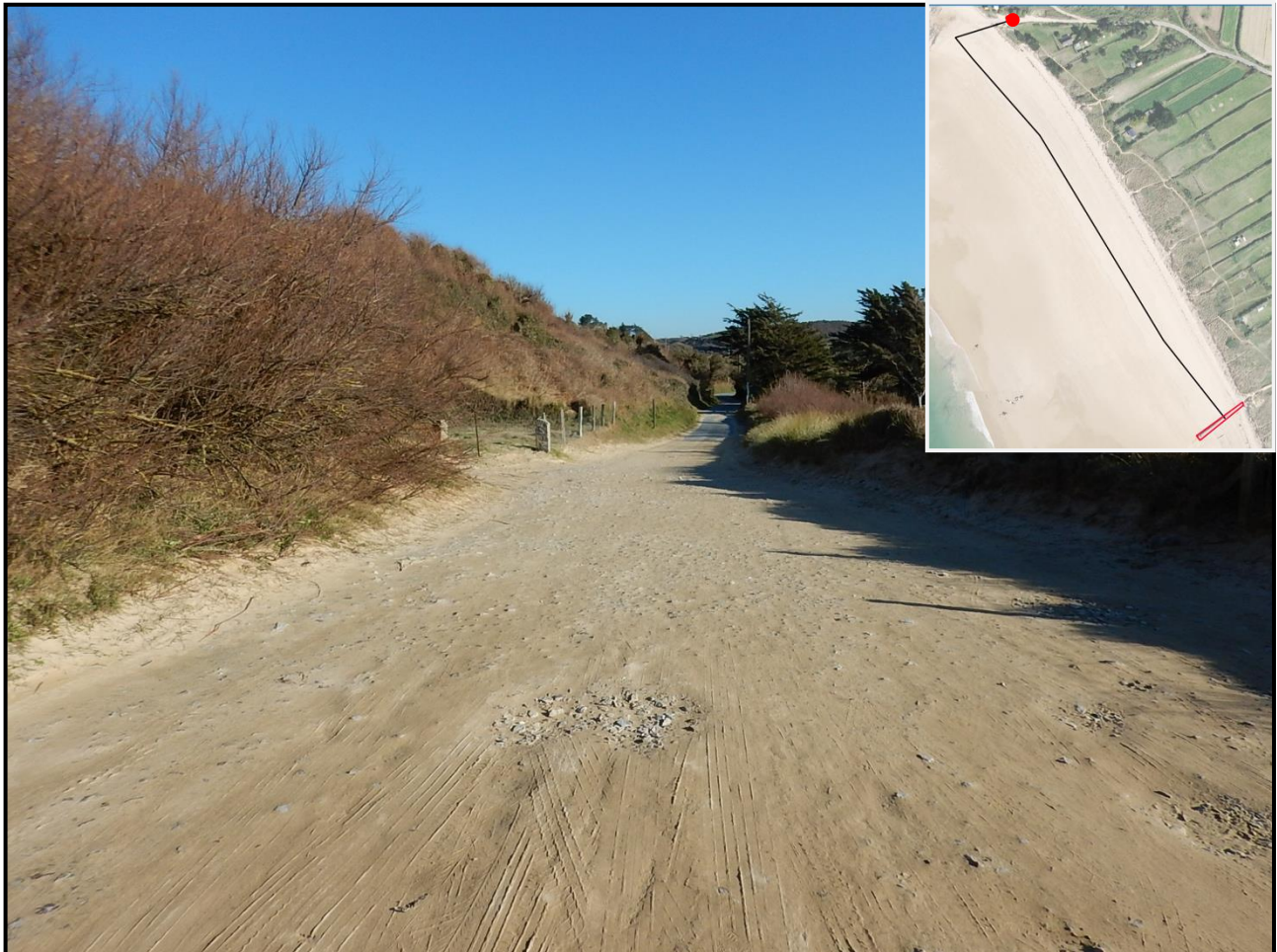
Figure 18. Chemin de Trompé-souris, seul accès à la plage par engins motorisés
