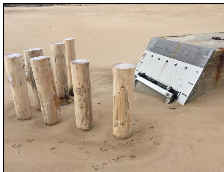
Figure 1. Clapet anti-retour de l'émissaire en octobre 2016
